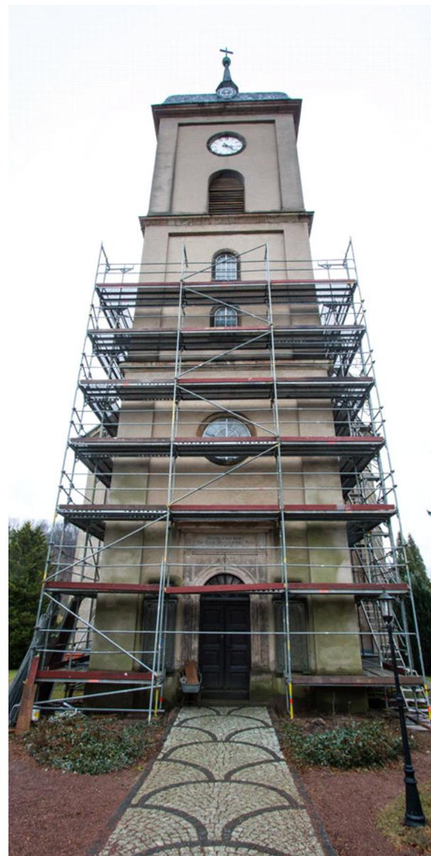
Foto). In den folgenden Wochen und Monaten werden an der Kirche die stark reparaturbedürftigen Dächer und Traufkanten von Kirchturm und Kirchenschiff sowie die Ostfassade am Turm erneuert.
